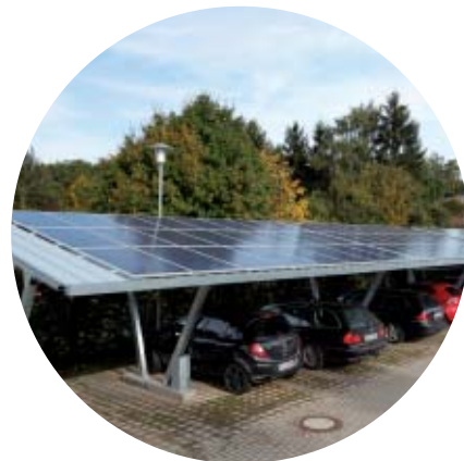
PV-Anlage auf dem Millerntor- Stadion auf St. Pauli.
